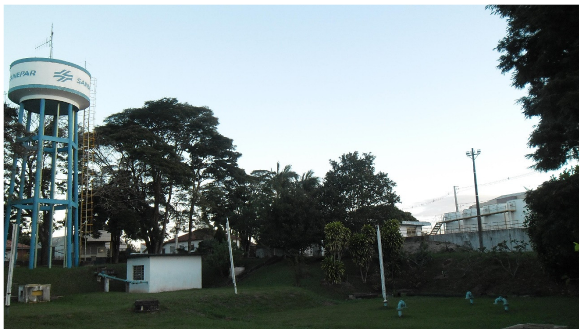
Arquivo da Sanepar – Reservatórios pátio da Estação de Tratamento de água.
