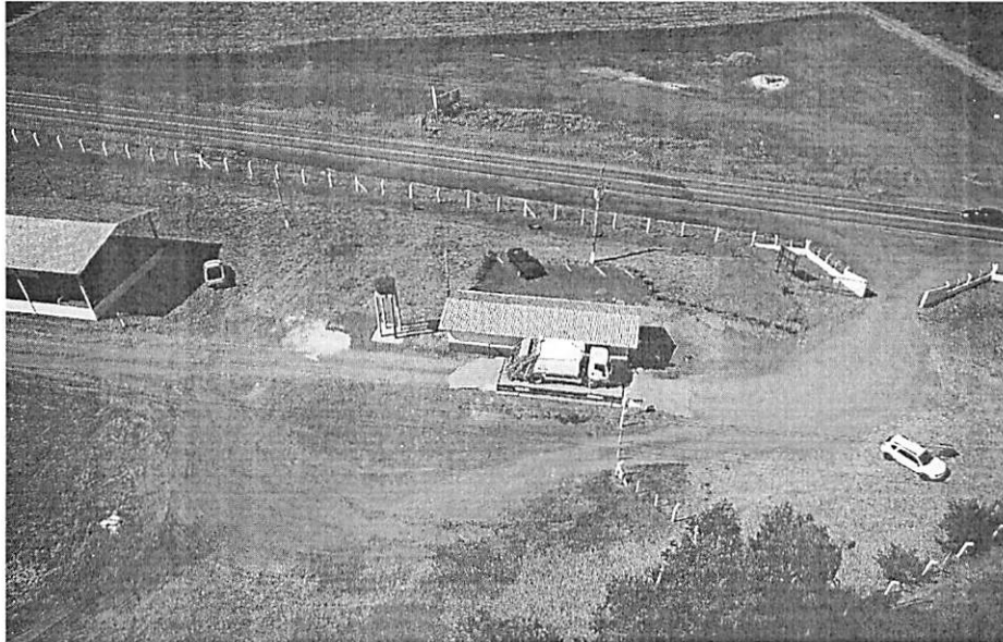
Figura 2 – Sede do CIAS/pesagem dos caminhões coletores, Paraná.
