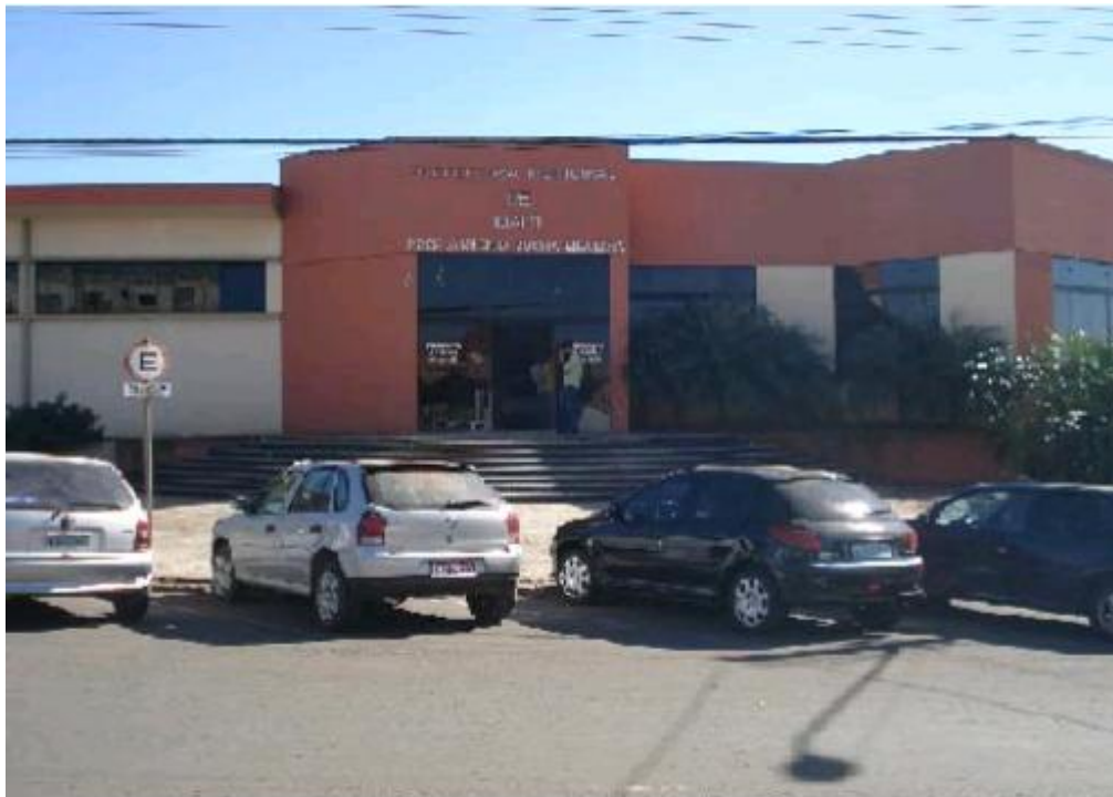
Figura 01: Prédio da prefeitura de Ibaítí – jul/08
