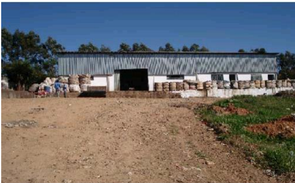
Figura 4: Galpão para armazenagem do material reciclável – Jul/08
